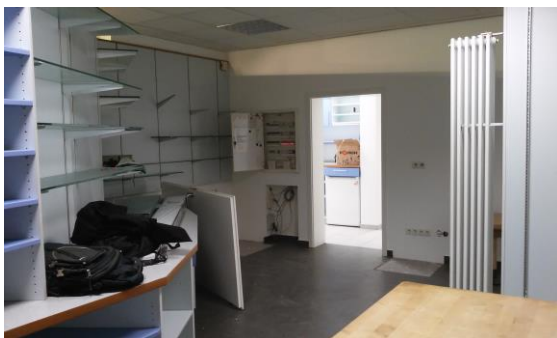
Umbau der neuen Räumlichkeiten
