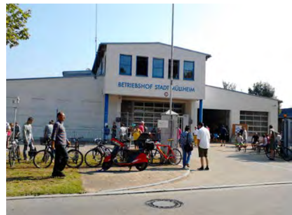
Städtischer Bauhof in Müllheim
